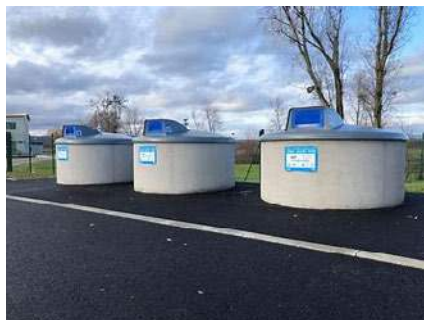
Exemple de containers semi enterrés
