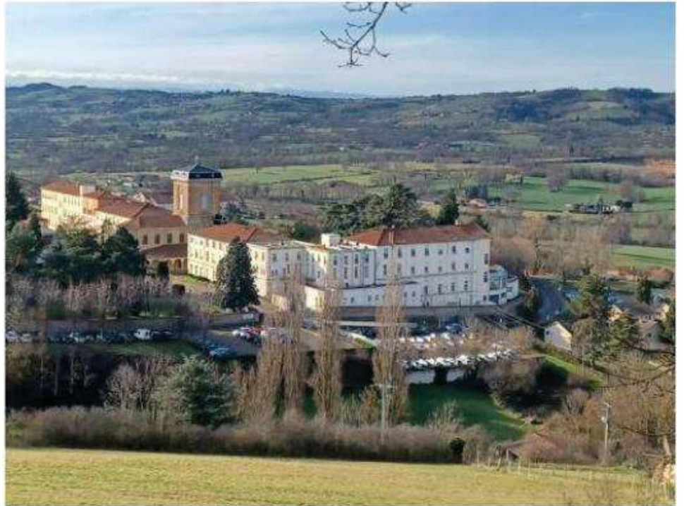
Le centre médical de l'Argentière, qui domine la vallée de la Brévenne, a besoin de soins. Photo Jean-Claude Voute
